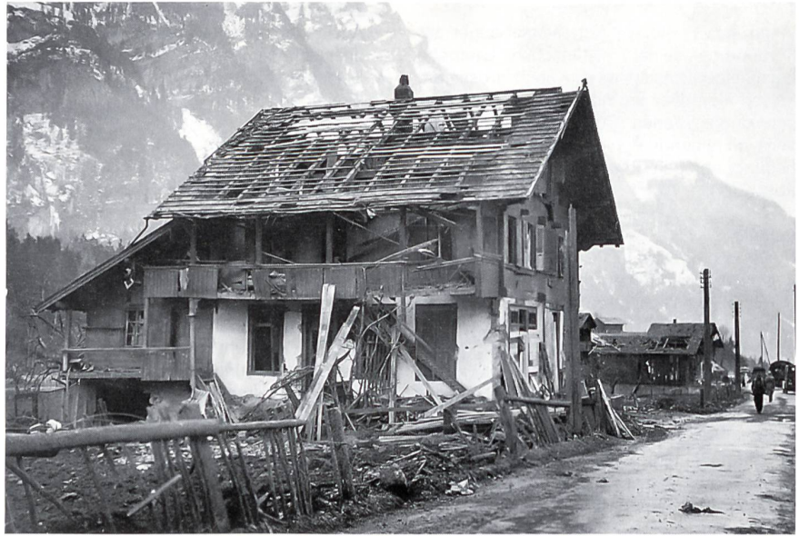
Gut ersichtliche Zerstörung am Chalet durch die Wucht der Explosion
